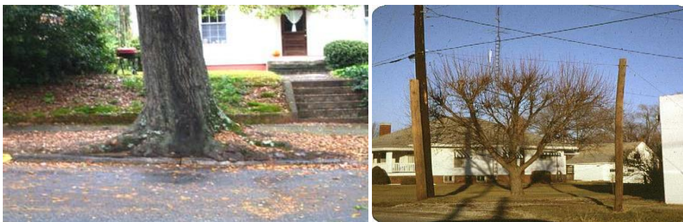
Los arboles de la calle mal plantados pueden resultar en infraestructuras heridas y condiciones de peligro.
